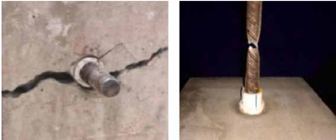
Рис. 11. Типові схеми руйнування експериментальних зразків за висмикування арматурного стержня з бетонного блоку [12]: а) схема руйнування типу висмикування, спричиненого розколом; б) схема руйнування арматури від розтягування
