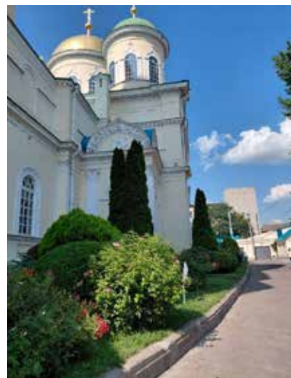
Рис. 3. Загальний вигляд СТКС [6]
