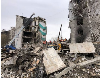
Рис.1. Зруйнована будівля внаслідок обстрілу
