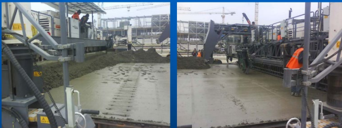
Укладання цементобетонної суміші після першого бетоноукладача SP-1500 наступний шар суміші цементобетонну укладається другим бетоноукладачем SP-1500;
