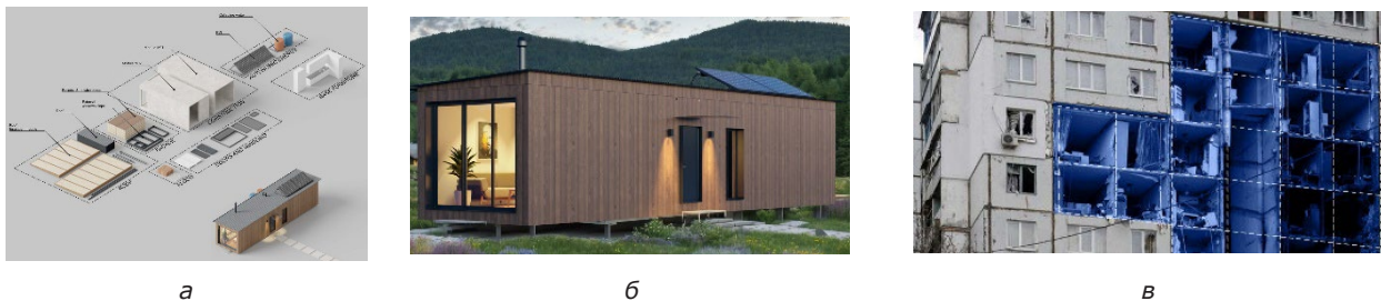
Рис. 13. Житлова автономна модульна одиниця, розробка "Collaba Architects" (м. Полтава); а – комплектуючі для житлового модуля; б – житлова одиниця у зібраному вигляді; в – використання модуля для пошкоджених будівель [34]
