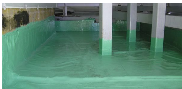
Рис. 4. Гідроізоляція фундаменту мембраною EPDM [4]
