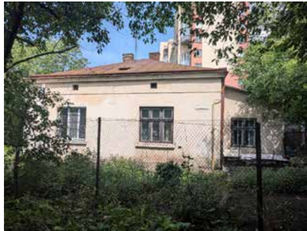
Рис. 11. Загальний вигляд будинку на вул. Кирилівська, 7 (фото автора)
