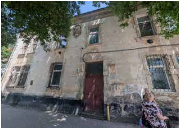
Рис. 8. Фрагмент чільного фасаду будинку на вул. Т. Шевченка, 132 (фото автора)
