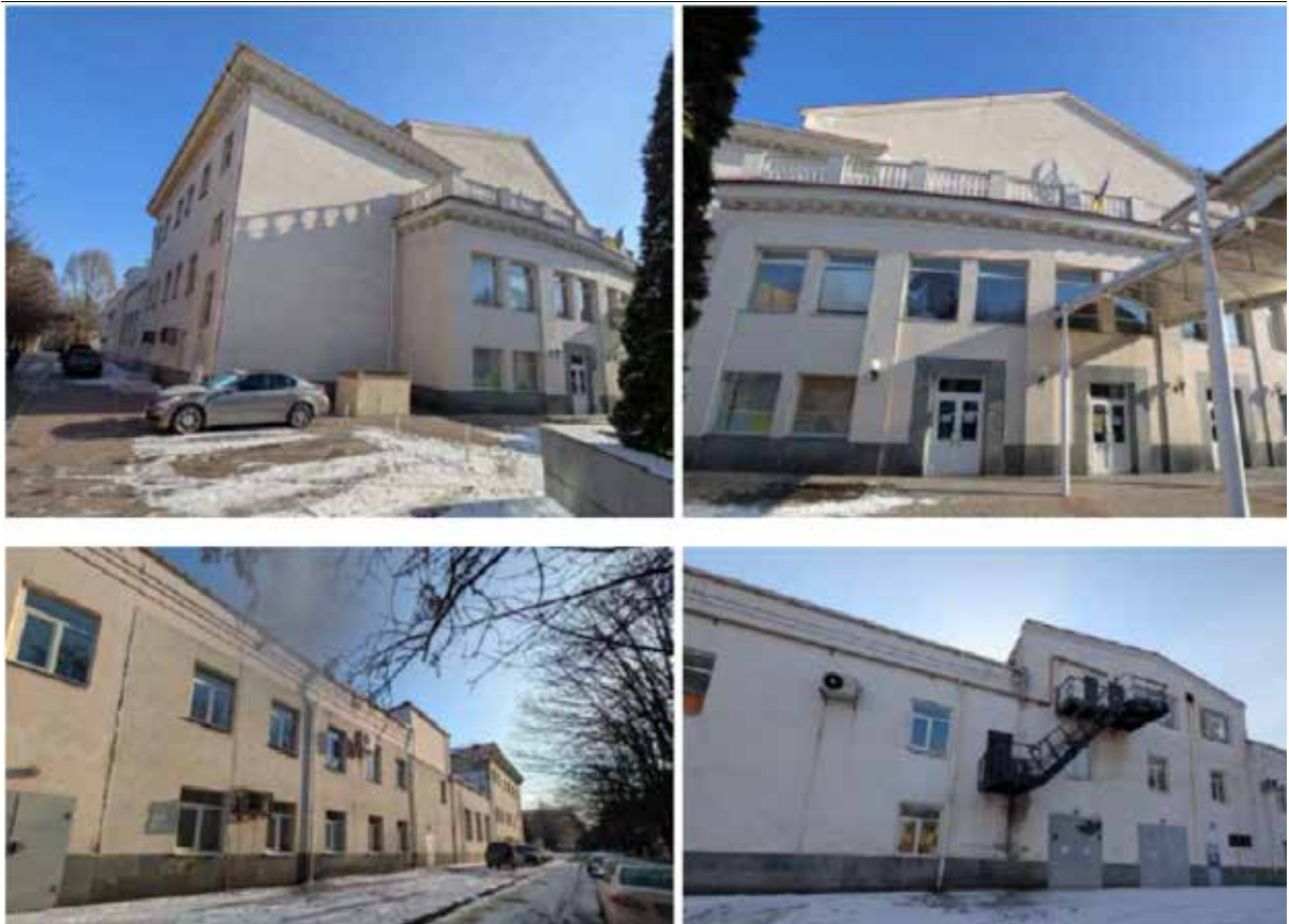
Рис. 11. Сучасний вигляд будівлі (фото Артема Петренка)
