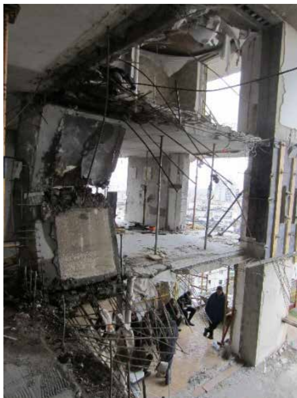
Рис. 1. Зруйновані залізобетонні елементи будівлі [12]
