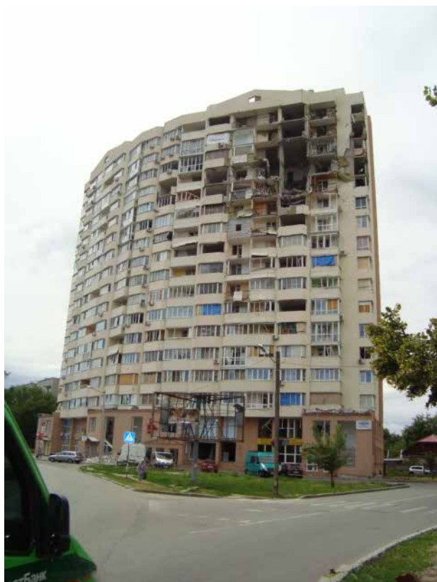
Рис. 1. Зруйновані залізобетонні елементи будівлі [12]
